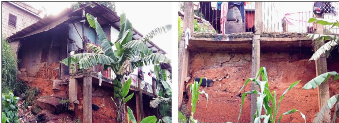
Figure 12 : Vue d'une maison d'habitation maintenue en suspension par des poteaux construits en béton armé à Etoa-Meki. Clichés : Djatcheu, 2015
