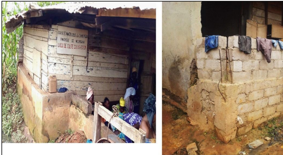
Figure 10. Vue des assises des maisons renforcées par des parpaings de ciment à Elig-Edzoa. Clichés : Djatcheu, 2015.
