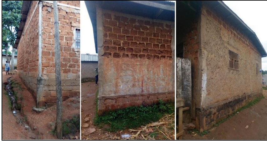
Figure 5 : Vue des maisons construites en briques de terre crue. Clichés : Djatcheu, 2015.
