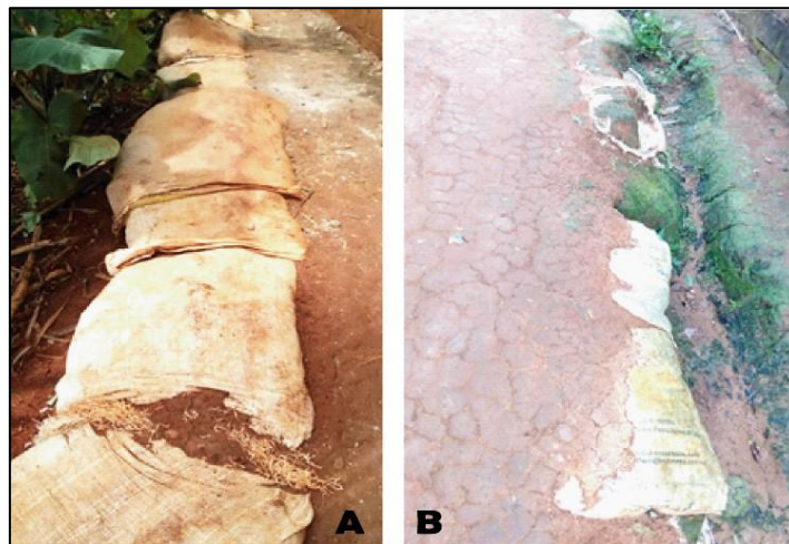
Figure 9 : Vue des sacs remplis de terre relevant d'une hauteur les berges d'une rigole à Melen (A) et à Mfandena (B). Clichés : Djatcheu, 2015.
