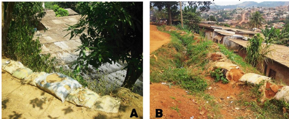
Figure 13 : Vue des sacs remplis de terre et empilés les uns sur les autres en amont des habitations à Etoa-Meki (A) et Oyom-Abang (B). Clichés : Djatcheu, 2015.
