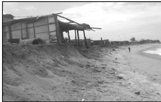
Figure 02 : Vue partielle du cordon externe en pleine érosion. Source : Cliché Takili, 2020
